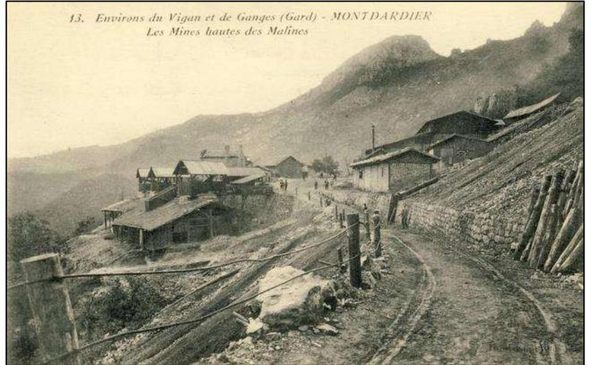
Au pied du plan incliné, une voie ferrée couverte partait en direction des trémies. La station de départ du transbordeur est localisée, sauf erreur, au niveau du bâtiment ouvert.
