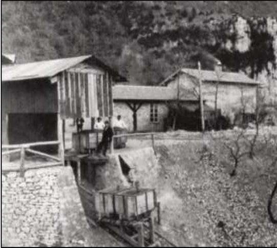
Ci-contre, la station de départ du plan incliné. Deux wagonnets pouvaient prendre place sur un chariot, perpendiculairement à la pente. Le plan incliné comportait une seule voie avec évitement à mi-parcours.
