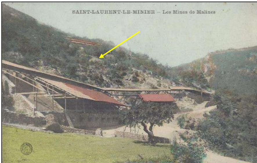
Avant la construction du transbordeur, les chars à bœufs partaient des trémies en direction de La Papèterie. La flèche jaune pointe le plan incliné. Au-dessus, on aperçoit les ateliers de triage des blends.
