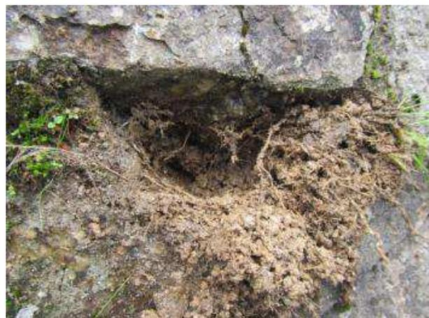
**Figure 7-11 : Mortier de jointoiement dégradé friable)**
