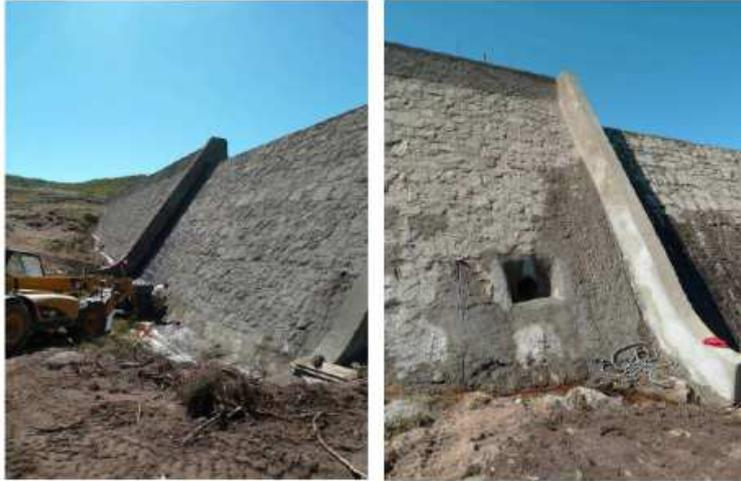
Figure 5-7 : Parement aval du barrage après travaux (2011)
