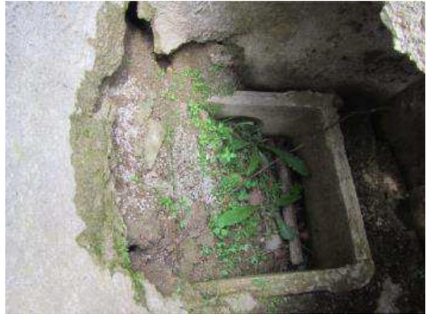
Figure 9-2 : Système de drainage engravé
