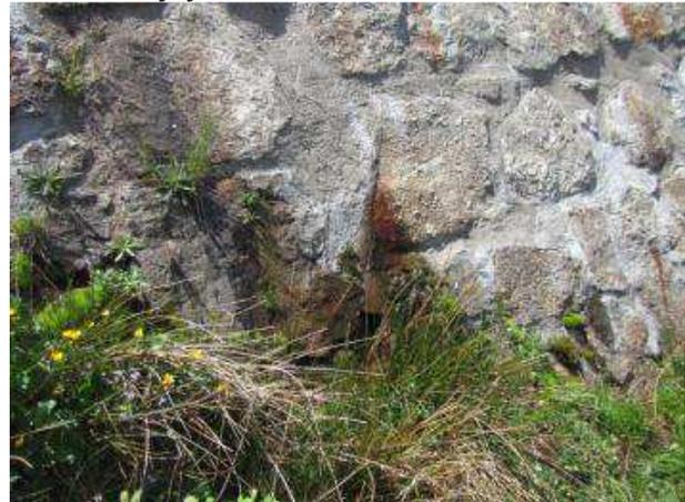
**Figure 7-9 : Fuite majeure au pied aval du barrage entre les plots n°7 et 8**
