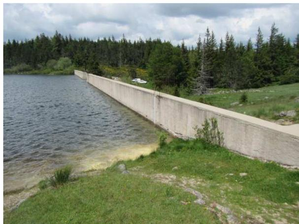
**Figure 1-4 : Parement aval du barrage**
