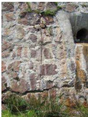
**Figure 7-10 : Trace de disqueuse sur le parement aval**
