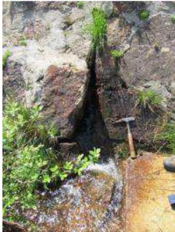
**Figure 7-8 : Fuite majeure au pied aval du barrage entre les plots n°6 et 7**
