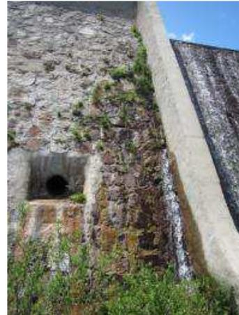
**Figure 7-7 : Fuite majeure au contact du bajoyer rive droite du déversoir**
