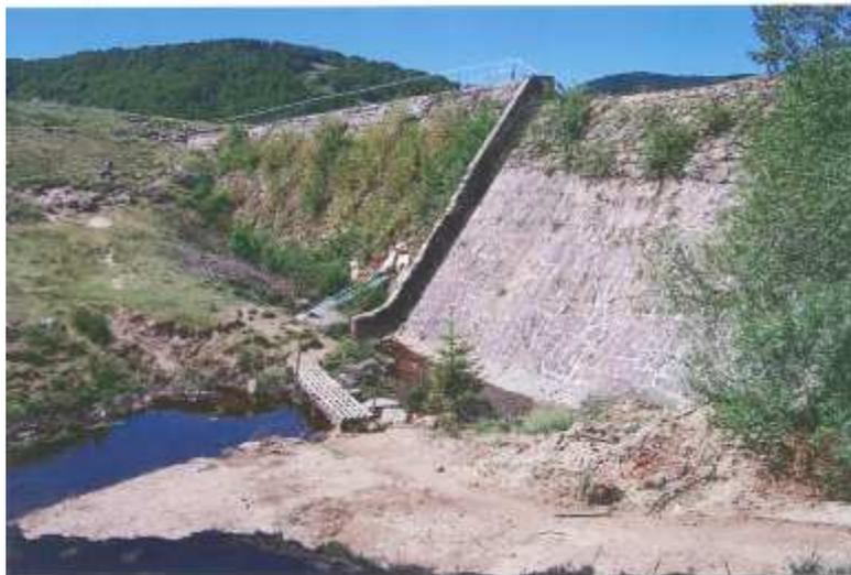
Figure 5-6 : Parement aval du barrage avant travaux (1999) [7]
