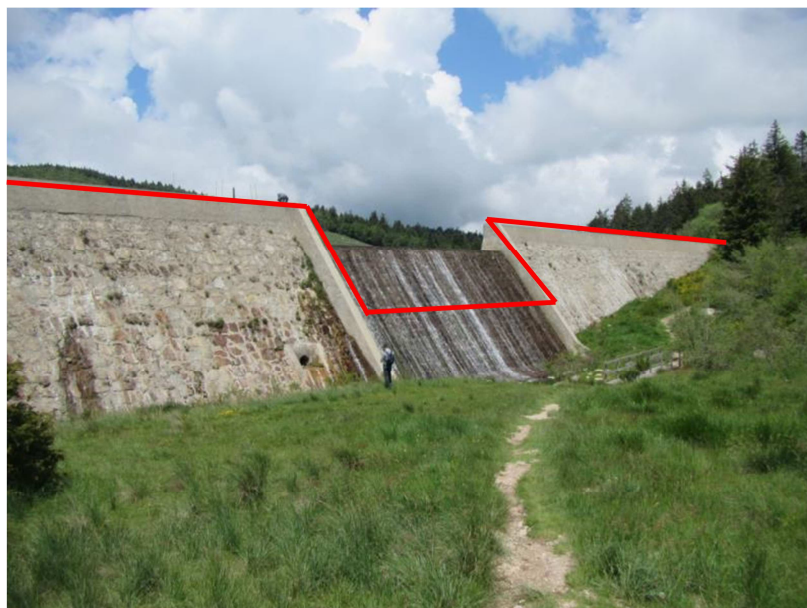
Figure 5-14 : Vue aval du barrage abaissé
