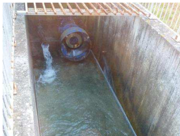
Figure 5-12 : Vanne à jet creux pour le débit biologique minimum
