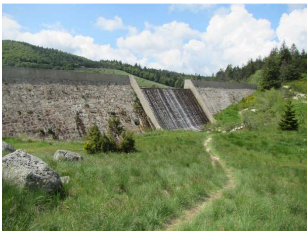
Figure 1-3 : Parement amont du barrage
