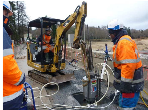
Figure 5-6 : Opérations de mise en tension d'un tirant
