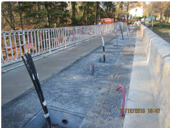
Figure 5-5 : Tirants mis en place après coulage du béton
