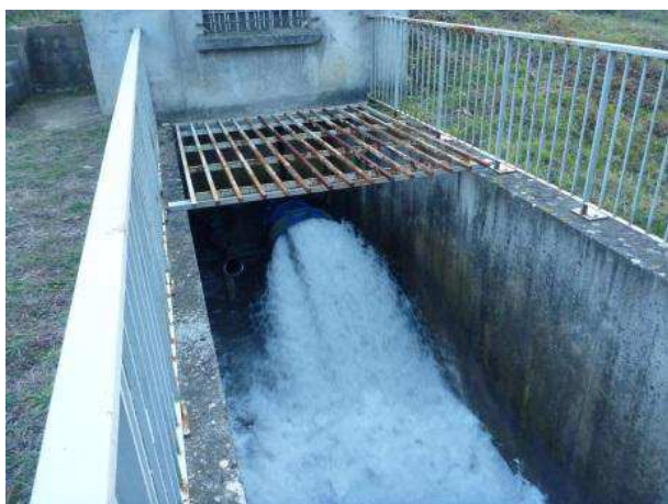
Figure 5-11 : Vanne de vidange à jet creux
