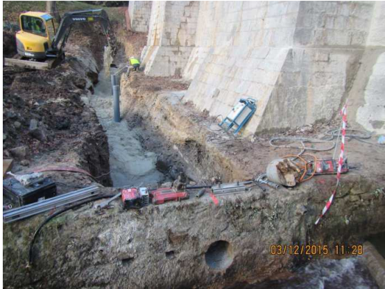
Figure 5-7 : Remblaiement de la tranchée drainante (barrage du Lampy)
