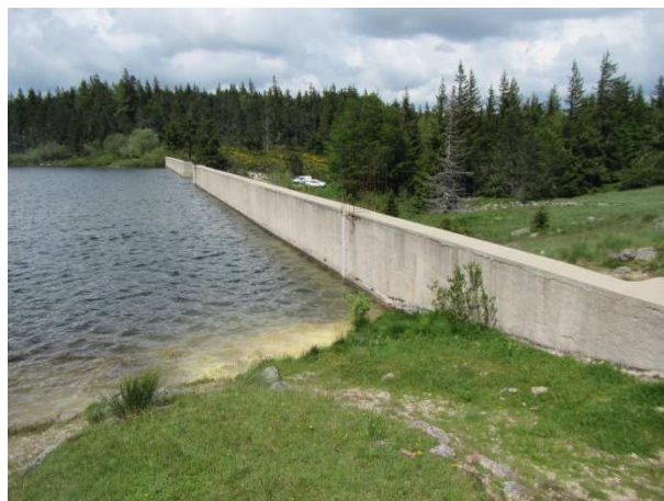
Figure 1-4 : Parement aval du barrage
