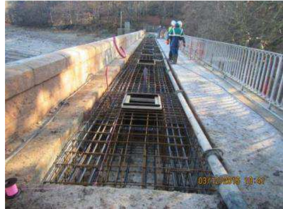
Figure 5-4 : Ferrailage de la longrine avec réservations au droit des tirants
