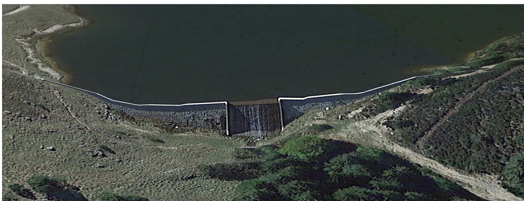
Figure 1-2 : Parement amont du barrage (source : Google Earth)
