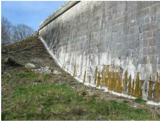
Figure 5-9 : Cunette de collecte (barrage de St Denis)
