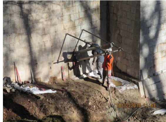
Figure 5-8 : Forage carotté d'un drain incliné (barrage du Lampy)
