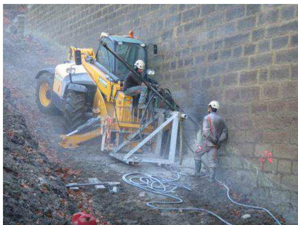
Figure 5-10 : Forages pour injections en pied amont
