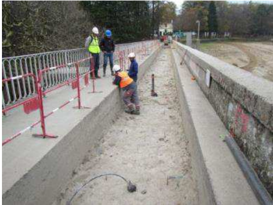
Figure 5-3 : Fouille de la longrine en crête
