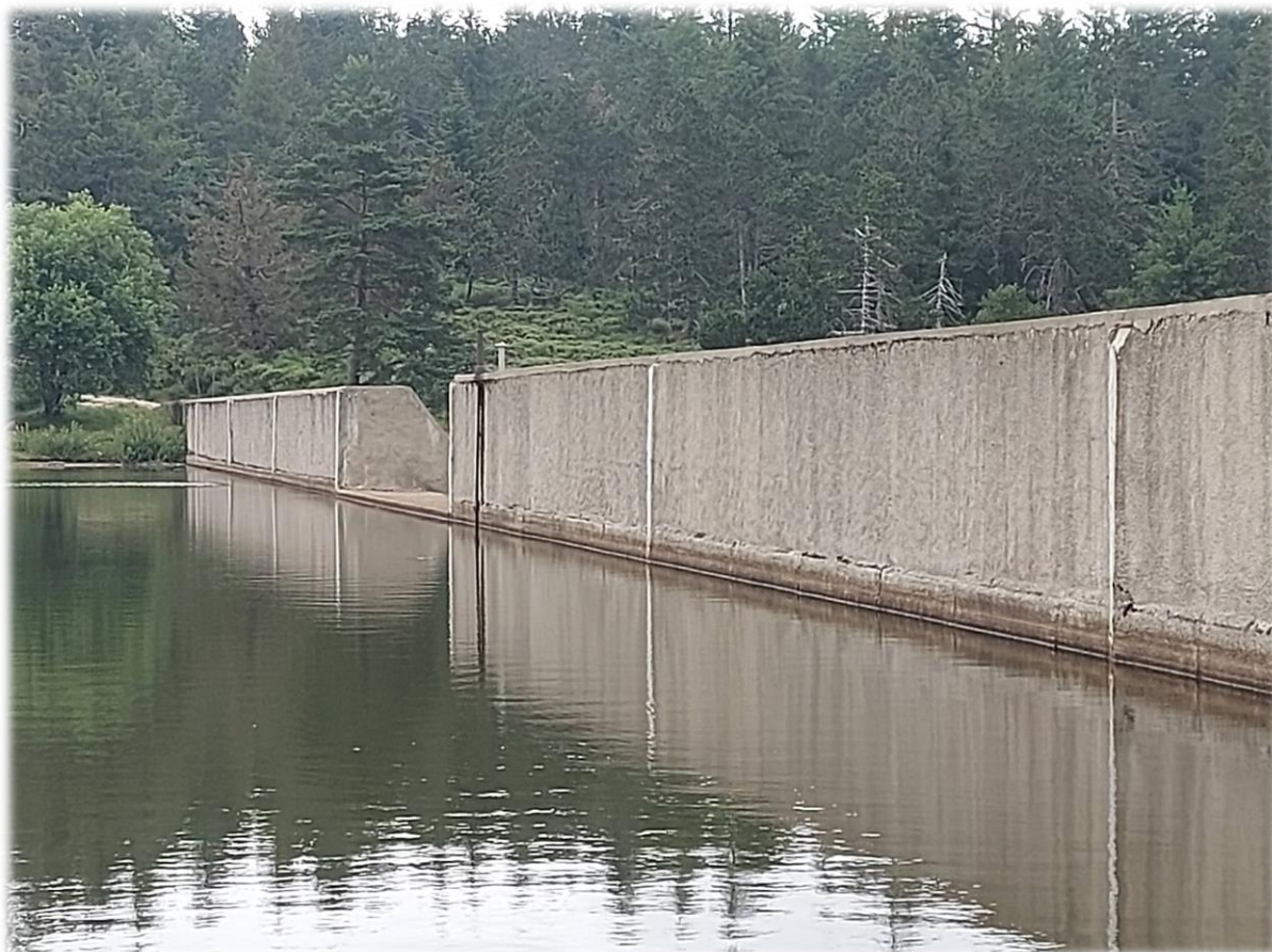
Niveau d'eau à 10cm du déversoir
