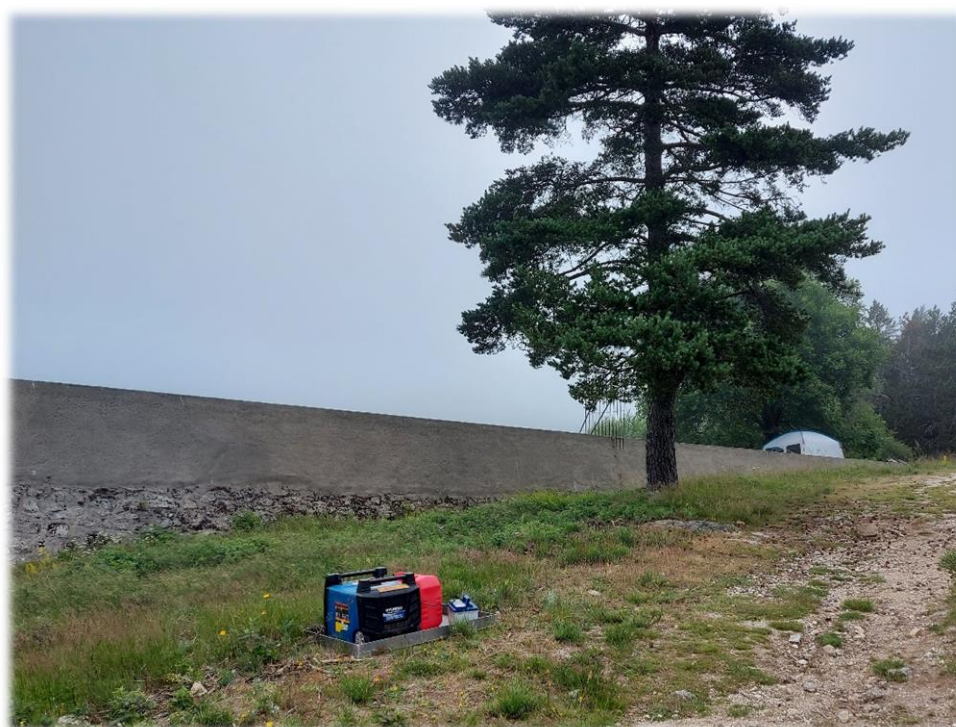
Installation du groupe électrogène
