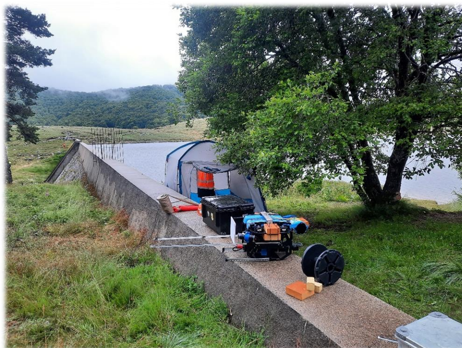
Installations de chantier JIFMAR en RG du barrage des Pises
