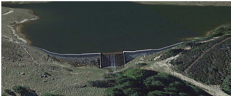
Figure 1-2 : Parement amont du barrage (source : Google Earth)
