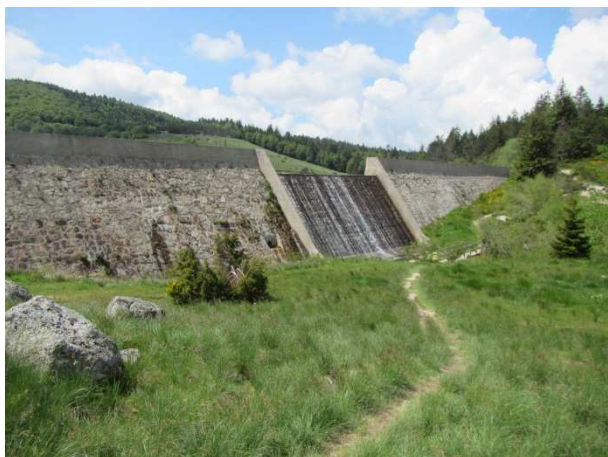
Figure 1-3 : Parement amont du barrage
