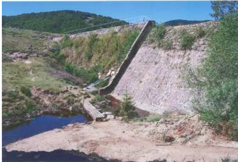
Figure 10-1 : Parement aval du barrage avant travaux (1999)
