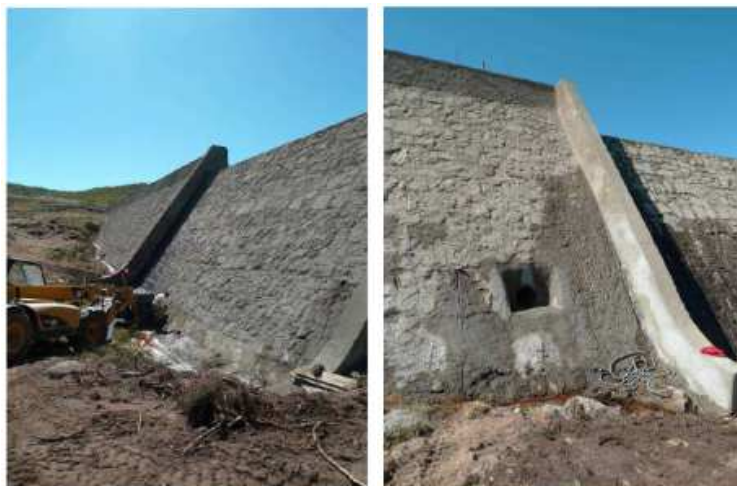
Figure 10-2 : Parement aval du barrage après travaux (2011)
