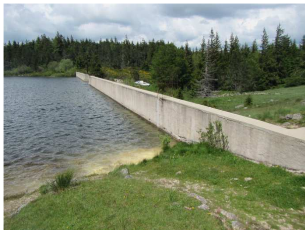
Figure 1-4 : Parement aval du barrage
