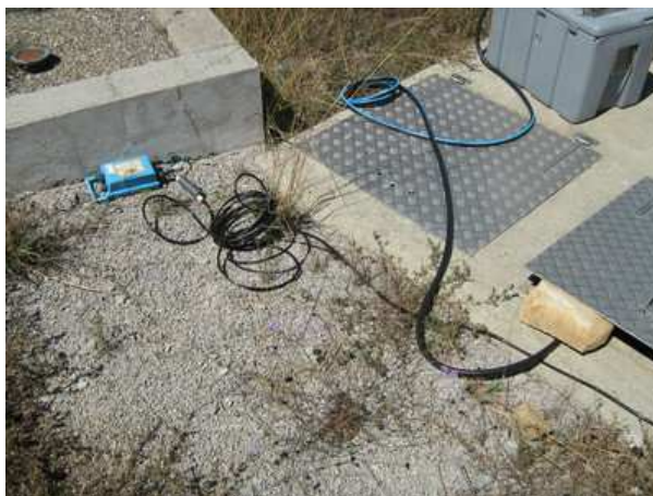
Octopus en entrée de station
