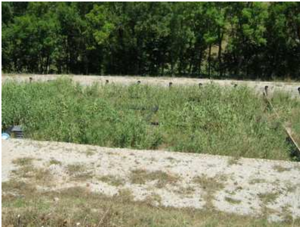
Station d'épuration : vue générale
