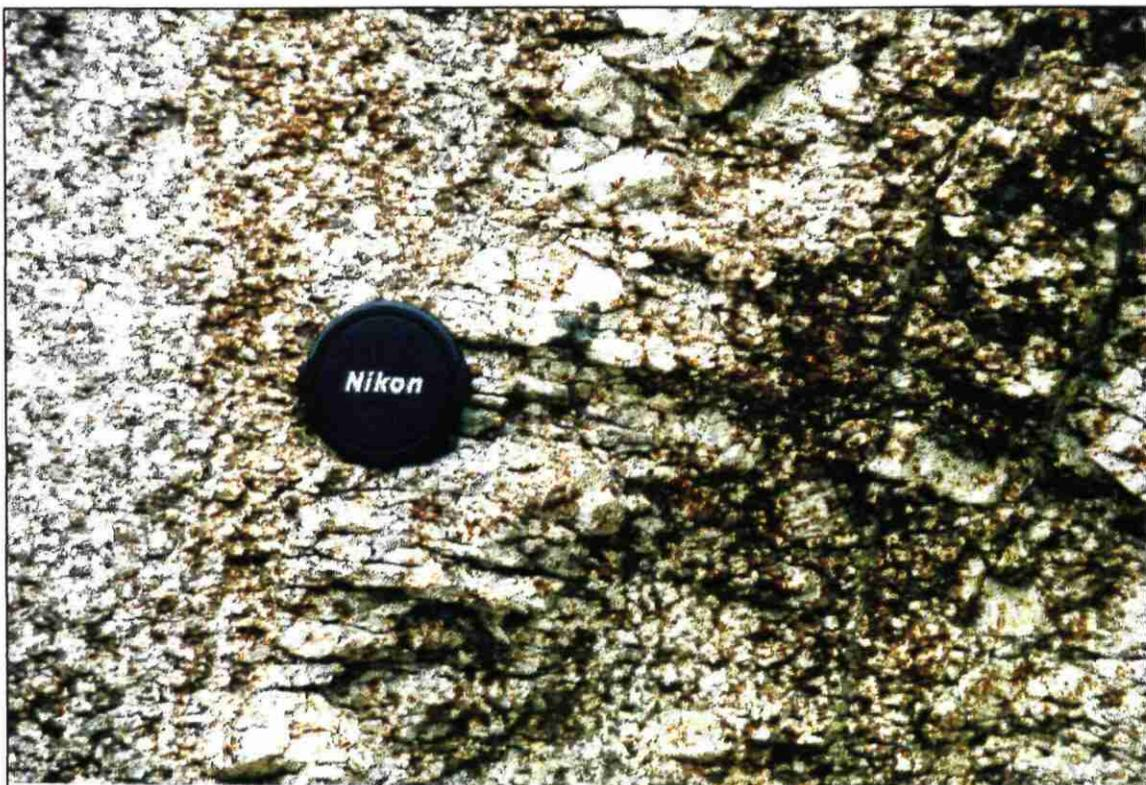
*Fig. 6 - Fissuration horizontale affectant un filonnet de quartz dans les arènes feuilletées (détail de la fig. 5)*
