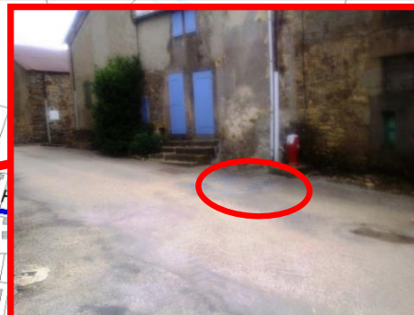
Fuite à côté du PI; Débit estimé 7,5 m 3 /h
