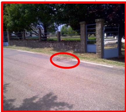
Fuite sur branchement
