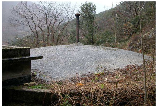
Vue extérieure du réservoir :
