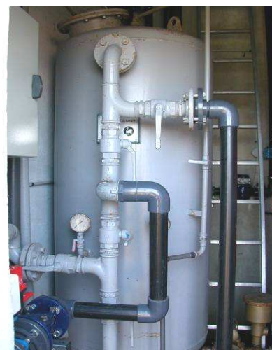
Vue intérieure (filtre à sable) :
