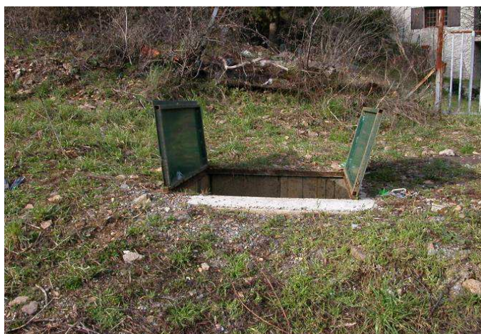
Accès au local (trappe) :
