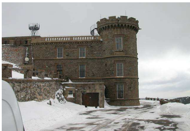
Vue extérieure du bâtiment abritant le réservoir :
