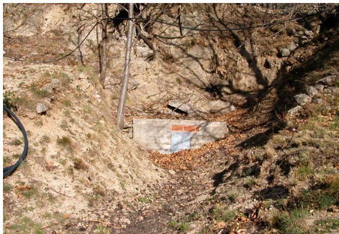
Vue extérieure du captage visité :
