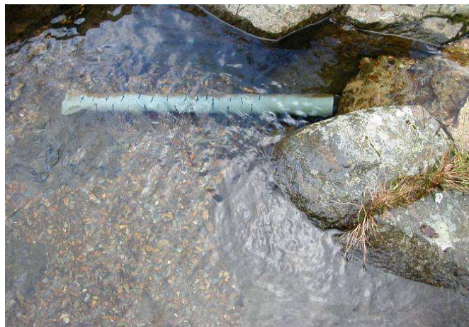
Captage (prise en cours d'eau) par crépine fendue :
