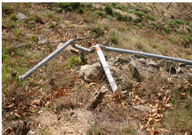
Raccord des 3 captages :
