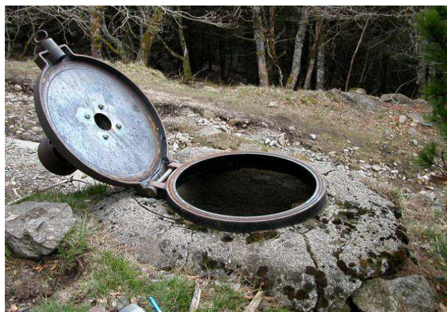
Vue extérieure regard bache de reprise :
