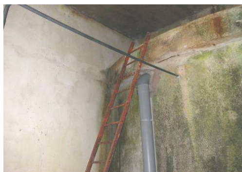
Réservoir et trop plein :
