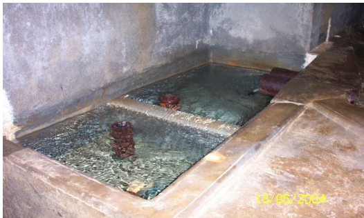
Vue intérieure du décanteur et du bac de prise
