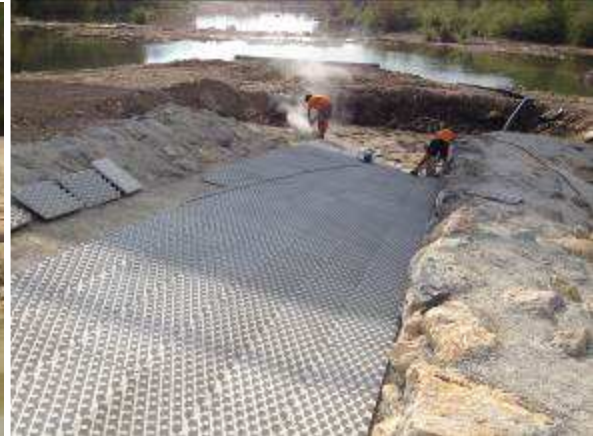
Génie civil de la passe à poissons du seuil de Saint Chaptès – Collage des dalles marco-plots sur le seuil de Moussac
