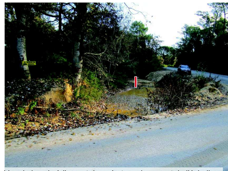
Vue du bassin à l'amont du gué et emplacement de l'échelle
