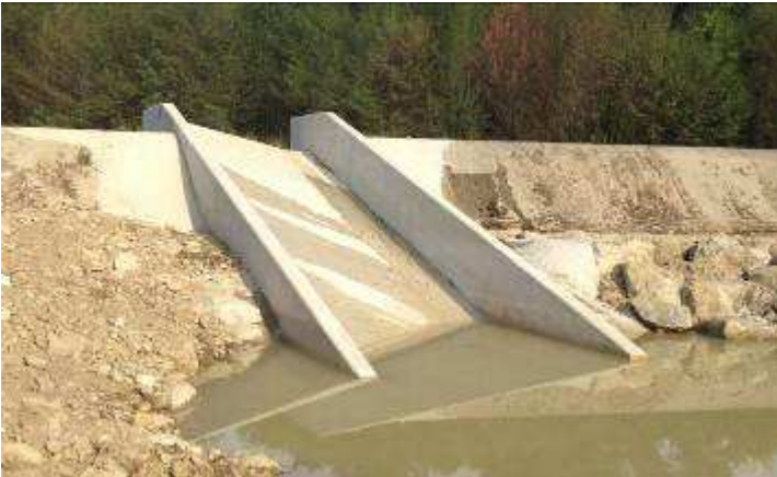
Génie civil de la passe à poissons du seuil de Saint Chaptès – Collage des dalles marco-plots sur le seuil de Moussac
