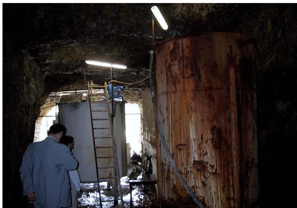
*Phot. 2 - Cuve de préparation du lait de chaux et cuve d'aération.*
