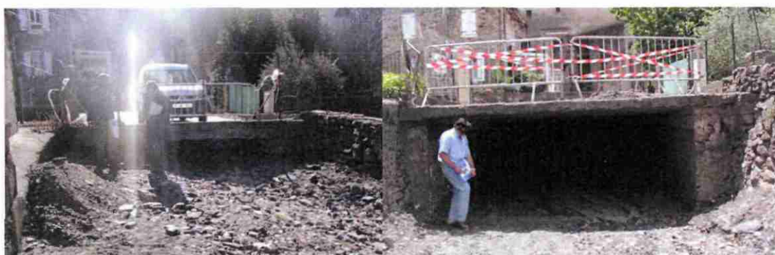
Section de 160 m en tranchée couverte (section 9 m 2 )
