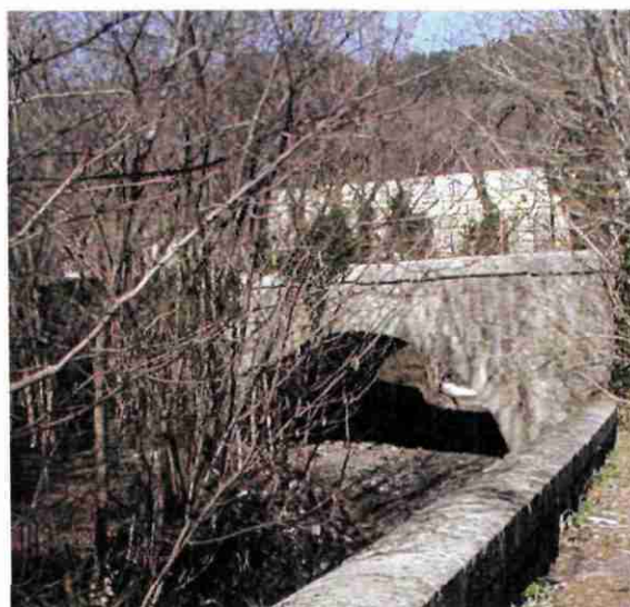
par la voie ferrée (ouvrage maçonné)
