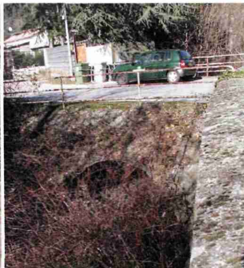
par une voie communale (ouvrage busé)
