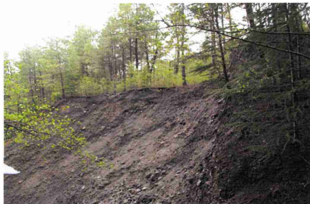
Vue 5 zone principale d'érosion 11/04/2008
