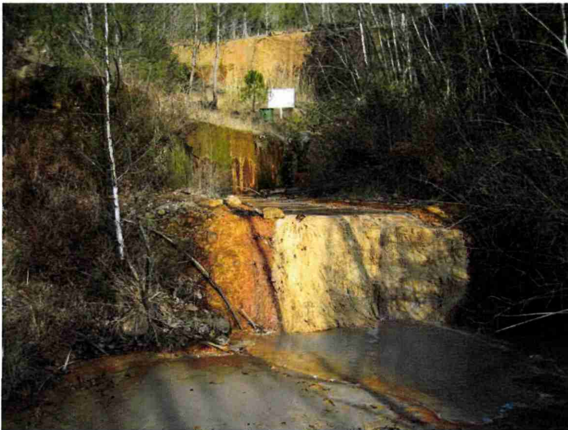
Figure 4 : Saint-Sébastien d'Aigrefeuille - Vue de la digue en arrière plan (31 janvier 2011 INERIS- BRGM)
