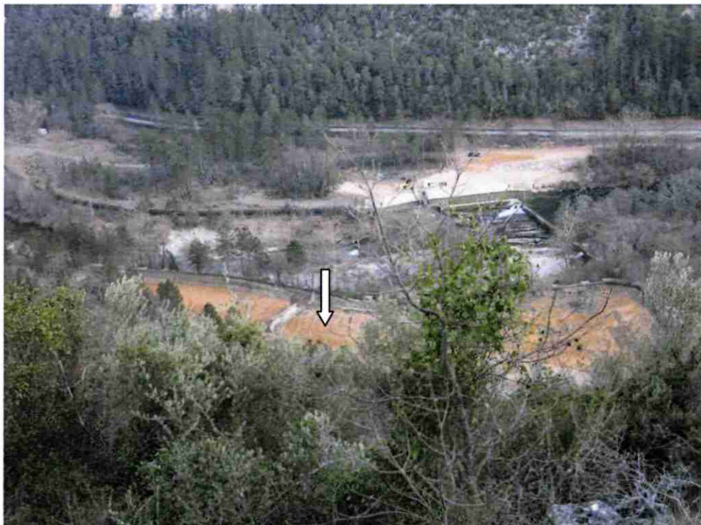
Figure 8 : Saint-Laurent le Minier - Remblais du site de la Papeterie et cas « zone particulière, habitée et cultivée » (flèche) (31 janvier 2011 BRGM-INERIS)
