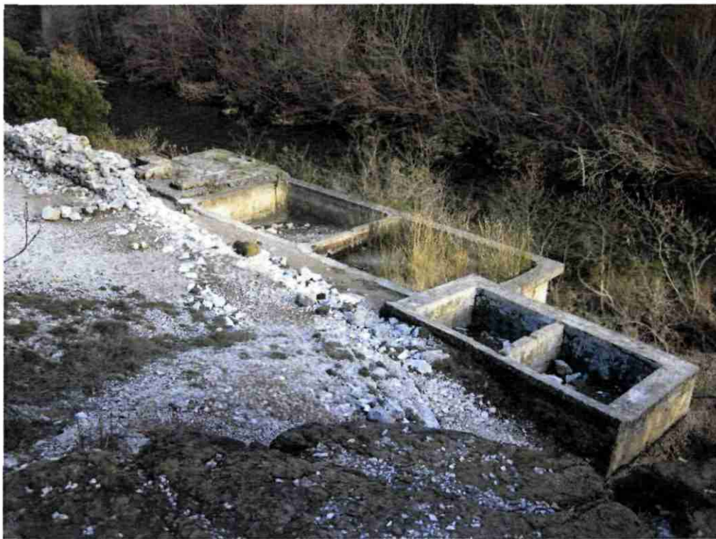
Figure 6 : Saint-Laurent le Minier- Bassins de décantation et Vis en arrière plan (31 janvier 2011 BRGM -INERIS)
