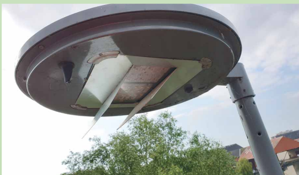
Lampadaire comportant plusieurs modules LED de température de couleurs différentes et munis de coupe-flux. Source : Yohann Tison - Ville de Lille.
