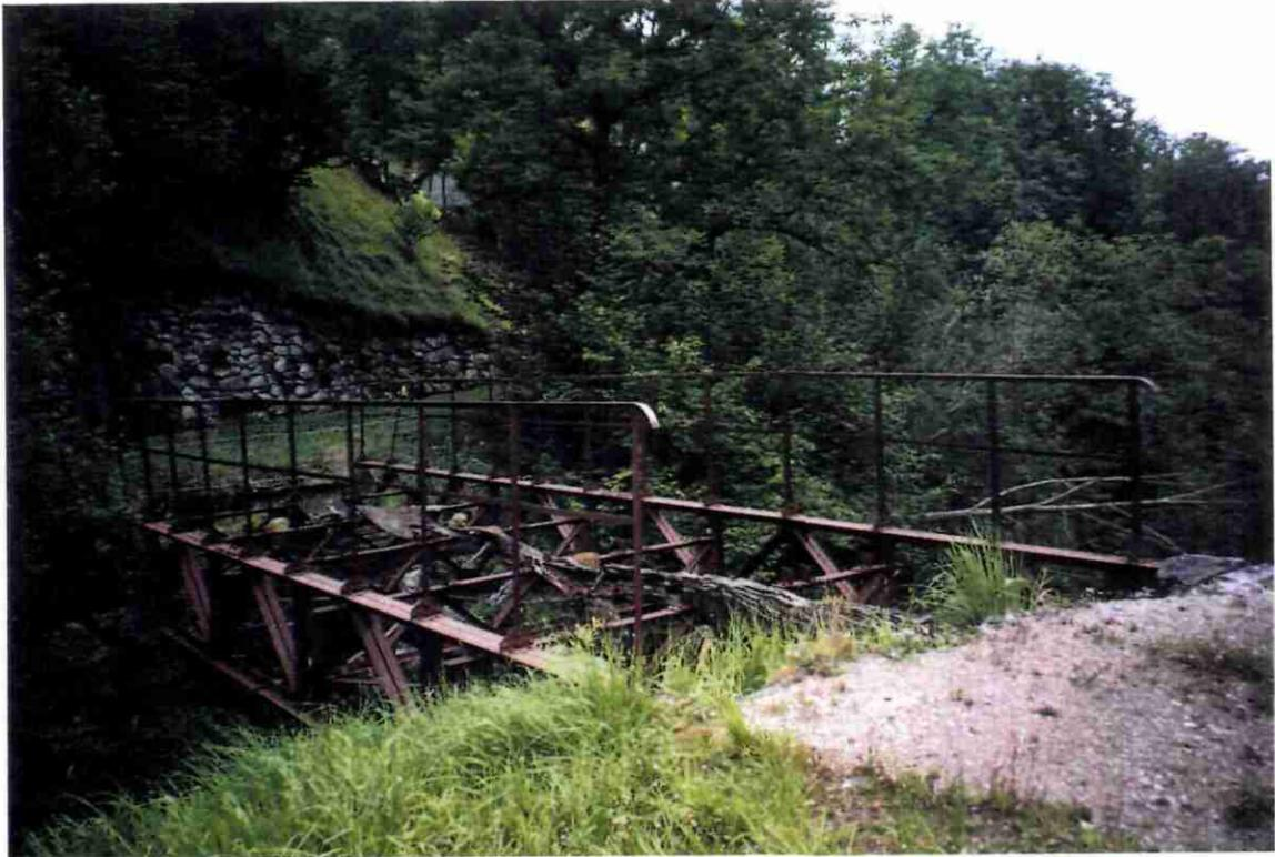
*Photo5 - Concession d'Arrens : Vue de la passerelle métallique au dessus du gave. On note l'absence du plancher.*
