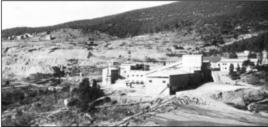
Photographie 5 : Vue sur l'usine définitive et la mine à ciel ouvert de Saint-Sébastien-d'Aigrefeuille en 1959 (source : archives DREAL 5.4.9)
