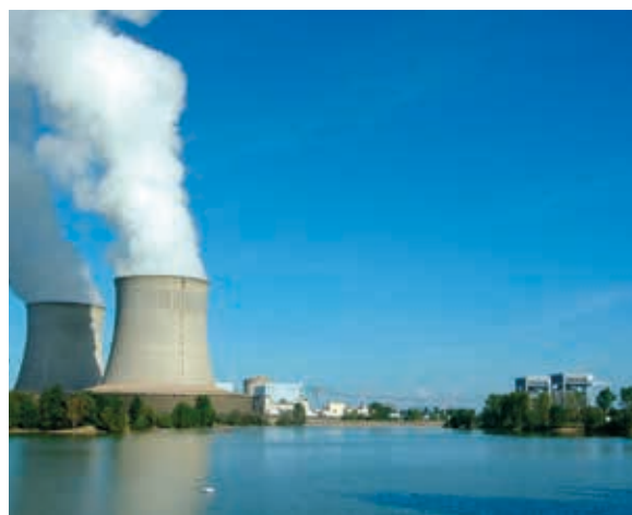
CNPE de Saint-Laurent-des-Eaux
