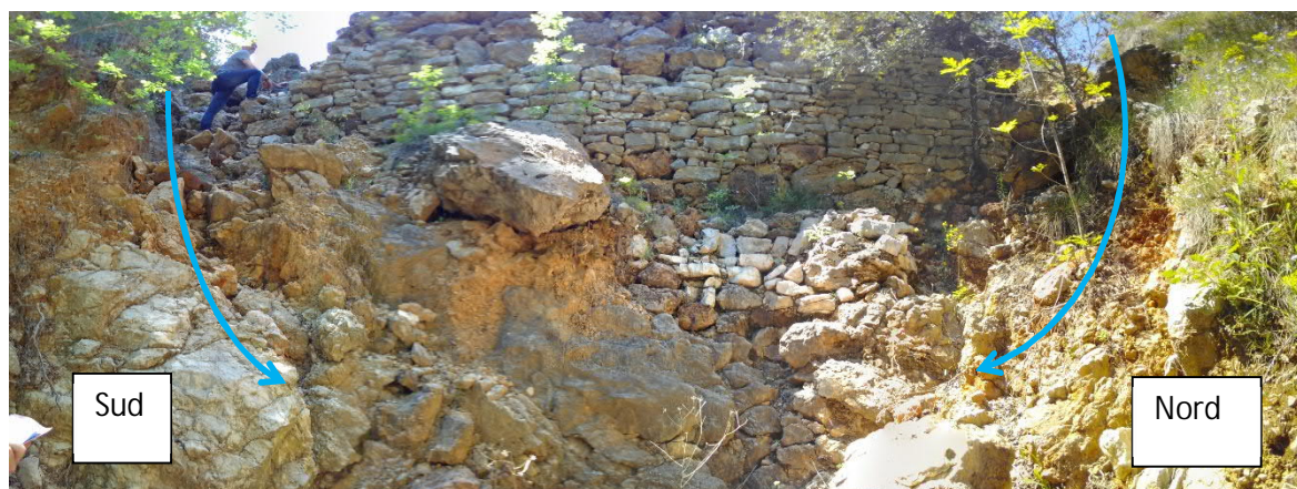
Figure 24 : Vue du muret de pierres sèches des haldes C04 depuis l'aval du talweg des Avinières.
