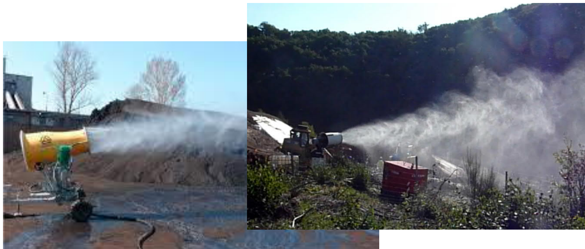
Figure 21 : Exemple de canons brumisateurs pour abattage des poussières sur des travaux de terrassement.
