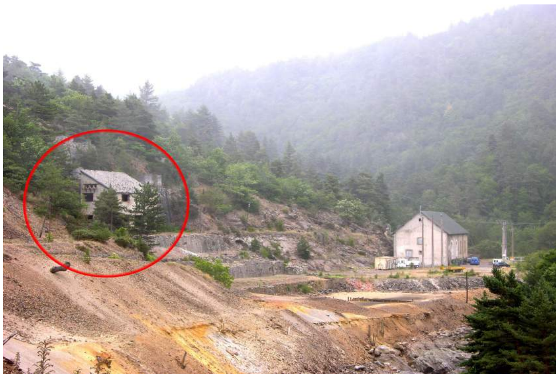
Ancien transformateur H.T.
