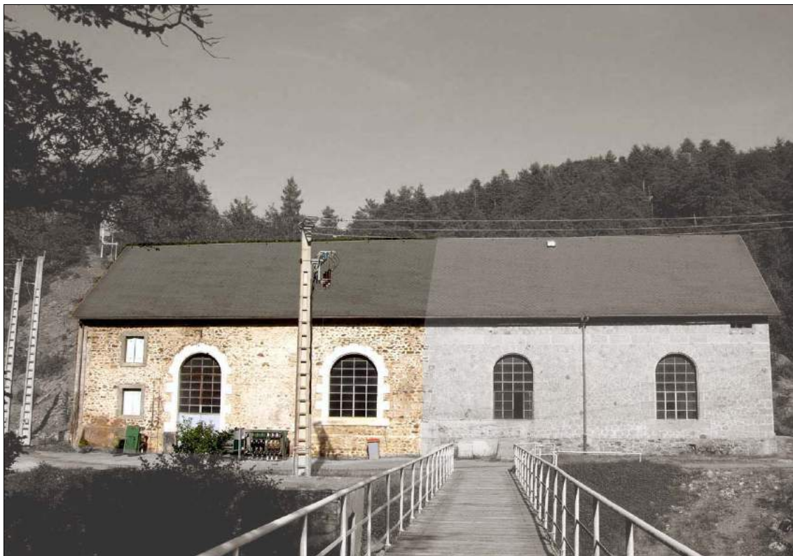
La centrale avec, à gauche, la partie thermique des années 1925
