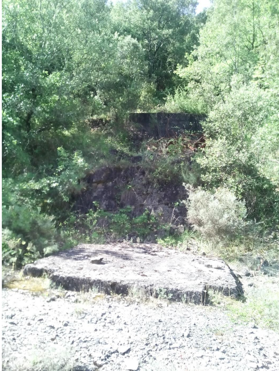
Figure 1 Un des puits de Durfort
