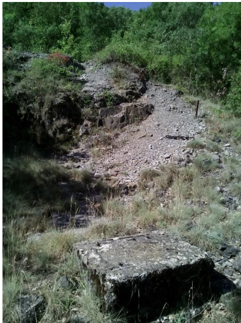
Figure 3 Dalle béton située en contrebas du puits
