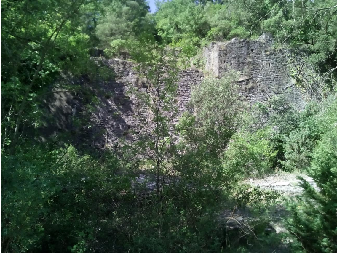
Figure 4 Ruines de la laverie de La Coste
