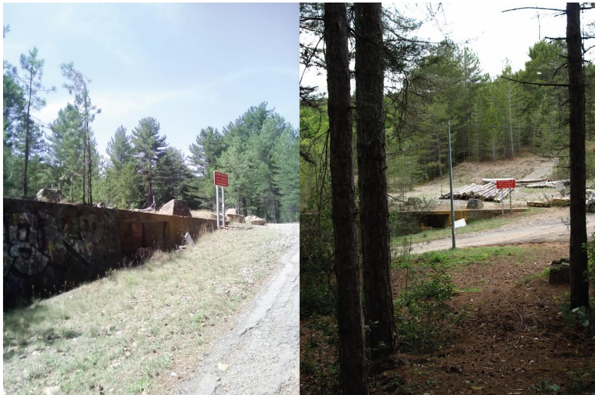
Figure 5 : Le puits en 1970 et aujourd'hui
