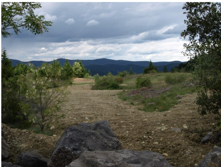
Figure 4 : Vue du haut de la digue de stérile
