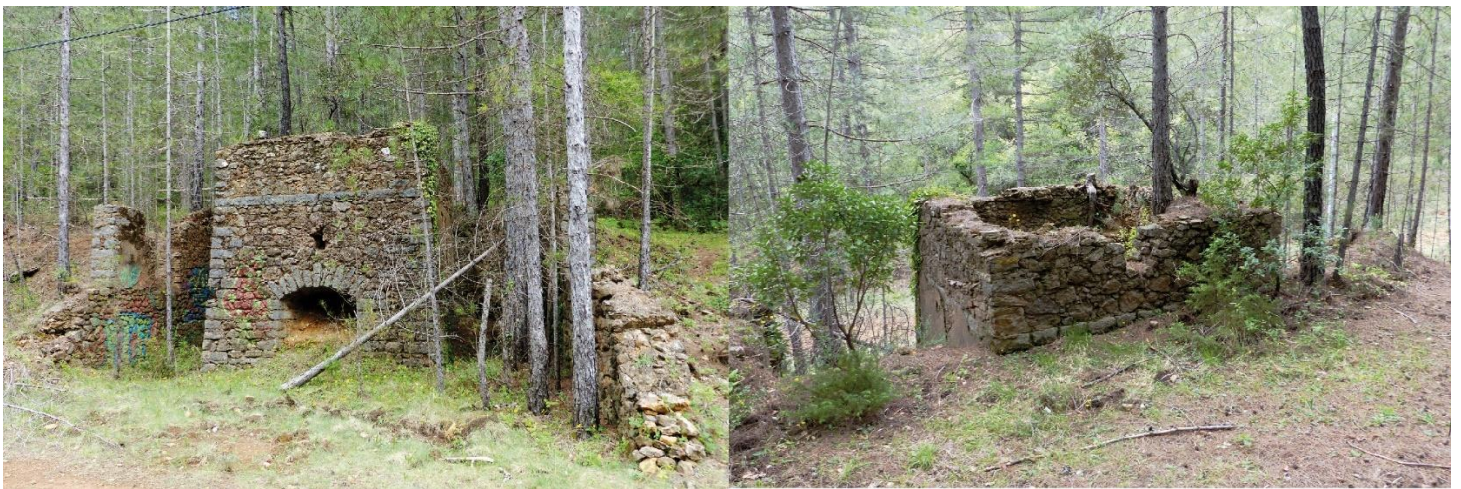
Figure 8 : Le four de grillage situé en-dessous du puits n°1
