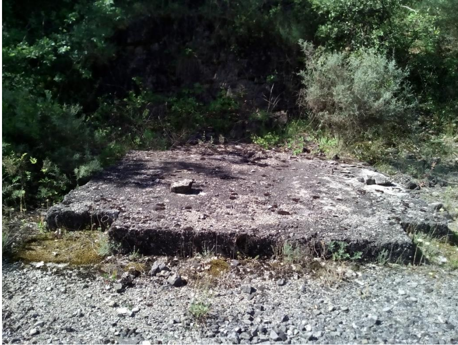
Figure 2 Le puits recouvert par une dalle en béton
