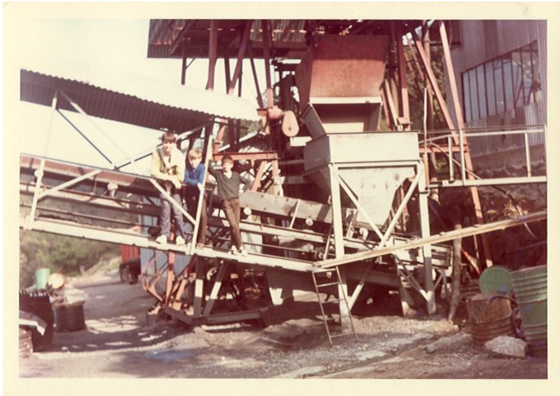
Figure 27 : Système de transport du minerai au niveau des cages du puits de la concession de La Coste à Durfort (Source : Archives privées)
