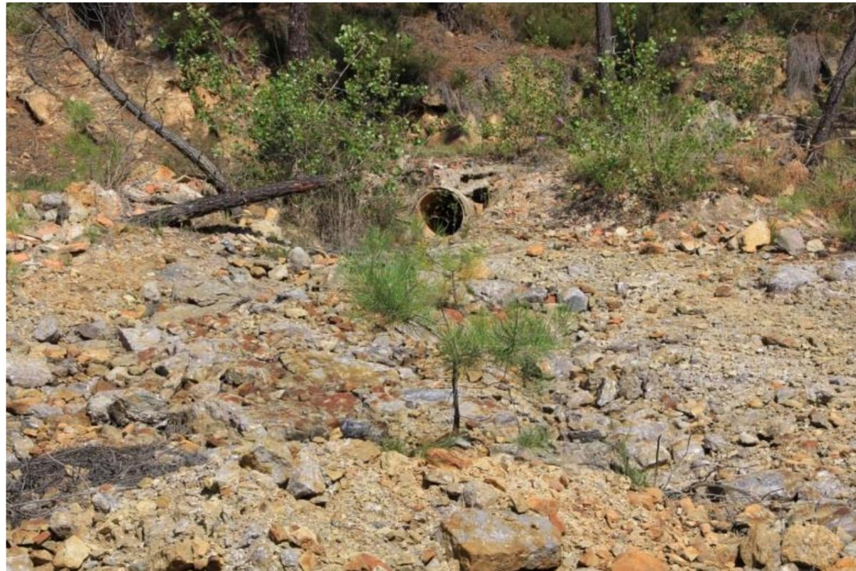
Page 75 Photo 43 – Buse rejetant les eaux de la route sur le 1<sup>er</sup> carreau d'exploitation
