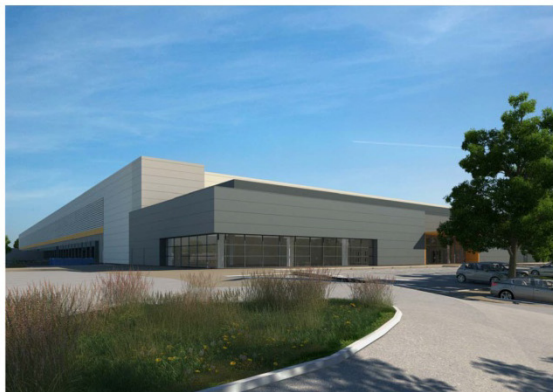
PC6-2 Vue des bureaux depuis l'entrée du parking
