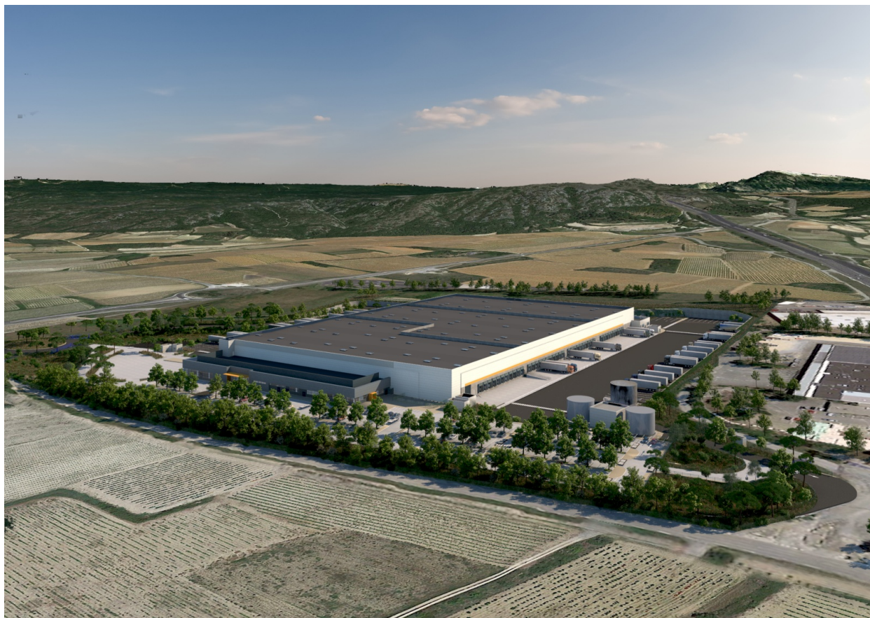
PC6-1 Vue aérienne du Sud-Ouest vers le Nord-Est
