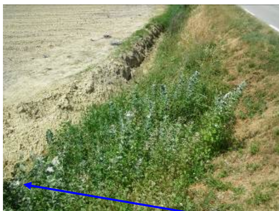
Photo 3 : Buse de traversée de la RD 192
