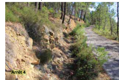
Photo 37 – Fossé le long du tronçon au-dessus du 1 er carreau d'exploitation
