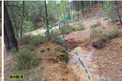
Photo 44 – Fossé rejetant les eaux de la route sur le 2 ème carreau d'exploitation
