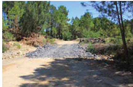
Photo 66 – Vue G – Piste sur le carreau d'exploitation sud
