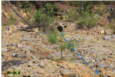
Photo 43 – Buse rejetant les eaux de la route sur le 1 er carreau d'exploitation
