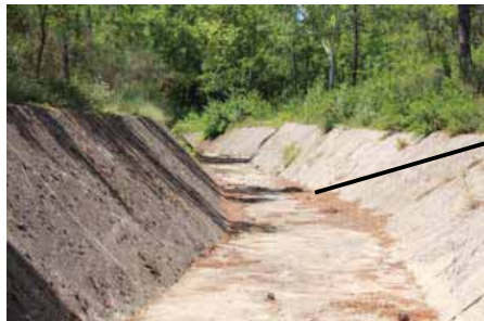
Photo 27 – Canal principal de déviation des eaux de ruissellement
