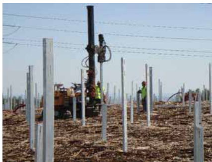
Photo 133 : Exemple de mise en œuvre de pieux battus (Source : Enersol)
