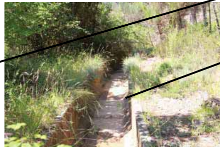
Photo 28 – Canal secondaire de gestion des eaux
