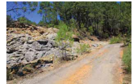
Photo 65 – Vue F – Bande de roulement localement détériorée
