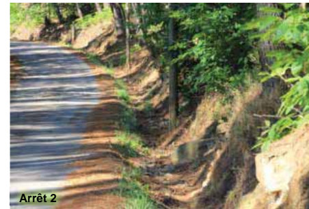
Photo 35 – Fossé le long du chemin entre la RD 217 et la station de retraitement des eaux usées
