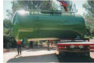
Photo 142 : Exemple de citerne incendie rigide
