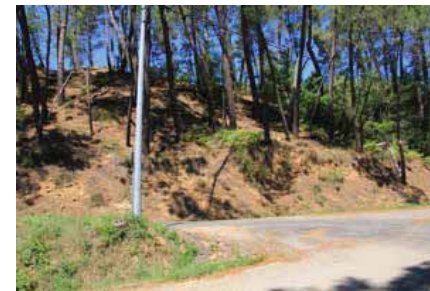
Photo 60 – Vue A – Jonction entre la RD 217 et le chemin vicinal n°4
