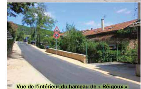
Vue de l'intérieur du hameau de « Réigoux »
