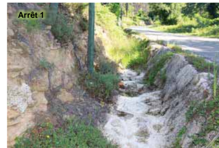
Photo 33 – Fossé bétonné le long de la RD 217
