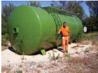
Photo 141 : Exemple de citerne incendie rigide
