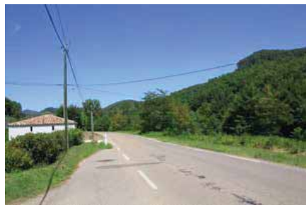
Photo 58 – RD 50 à hauteur de Générargues
