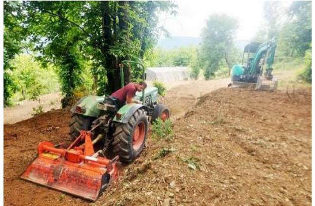
Pré-CEM : Passage du tracteur attelé d'un rotovator pour décompacter et aplanir la terre. Avec la pelle mécanique, seuls passages d'engins à essence.
