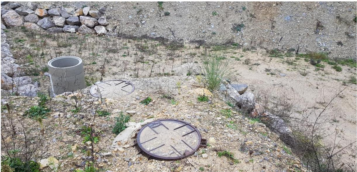
**Figure 7** : Photographie du décanteur/déshuileur et des regards d'entretien et de vidange du bassin de rétention en aval sud-ouest du site. Vue vers l'ouest.
