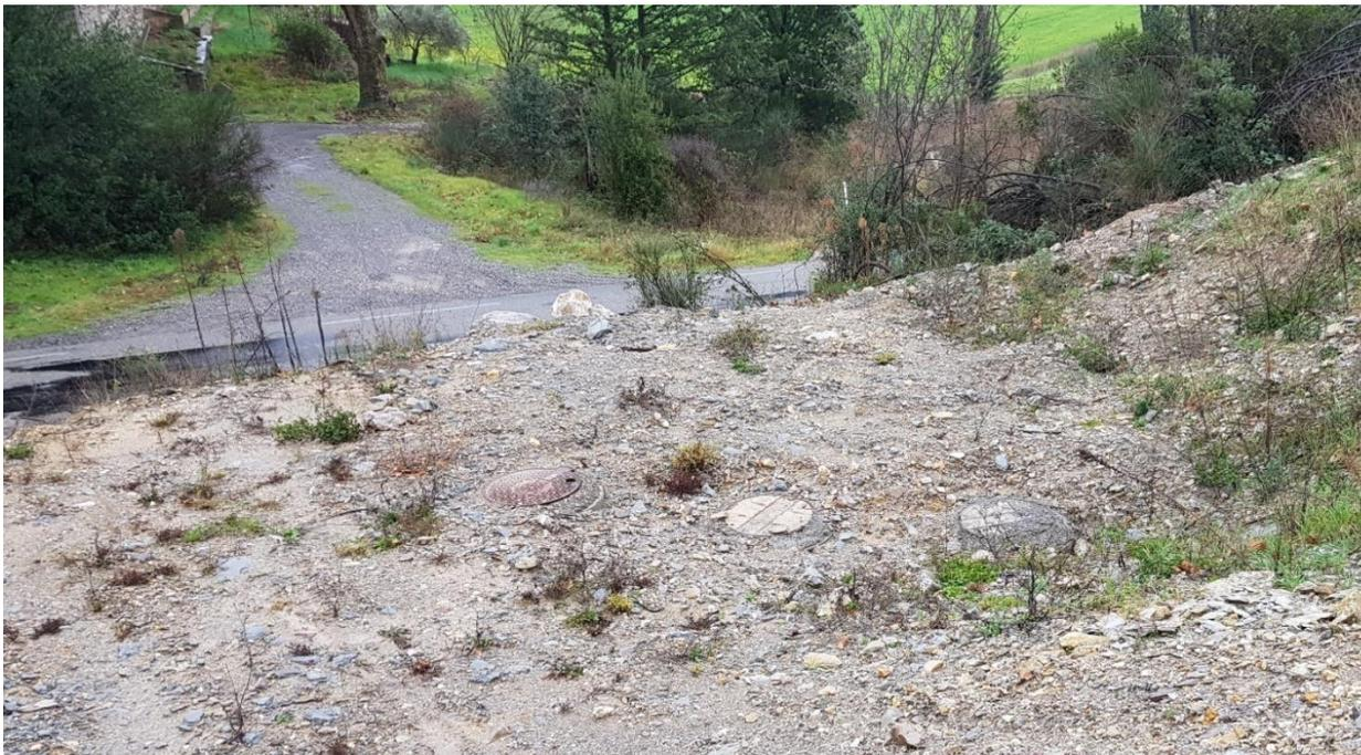
**Figure 9** : Photographie du décanteur/déshuileur et des regards d'entretien et de vidange du bassin de rétention en aval sud-est du site. Vue vers le sud.
