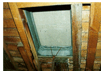
Tabatière dont la vitre a été remplacée par un carreau d'éternit pour atténuer la lumière du jour dans les combles de l'église de Durbuy, Province de Luxembourg. (© J. Fairon, CRC-I.R.Sc.N.B.)
