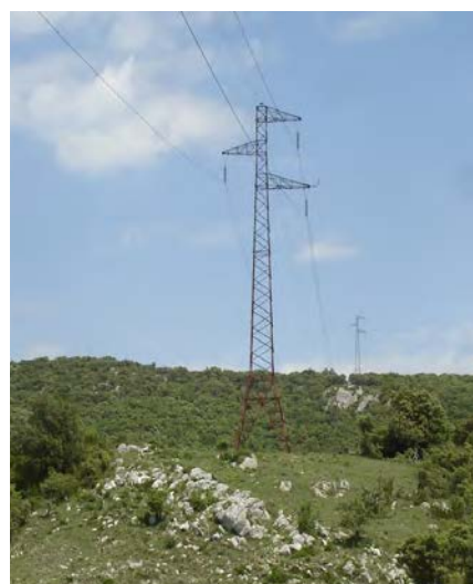
Ligne 63 kV faisant l'objet de travaux de maintenance
