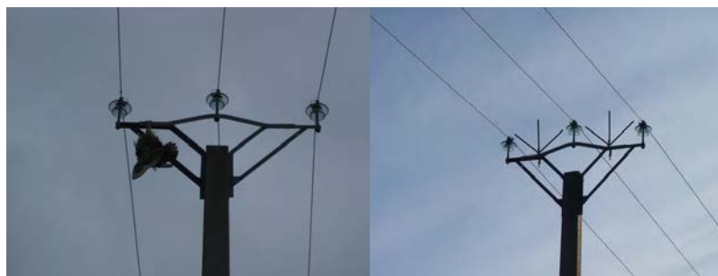
Poteau meurtrier à Conqueyrac à gauche et après sécurisation à droite
